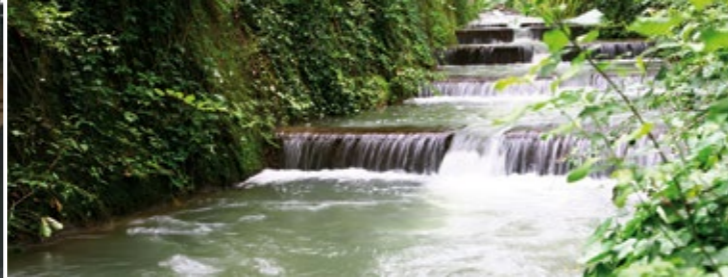
Zwei Fischtreppe ermöglichen Fischen, Krebsen und Larven, das Kraftwerk zu passieren.
