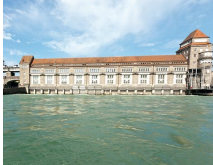
Mit 700 Millionen Kilowattstunden versorgt das Wasserkraftwerk Laufenburg rund 200.000 Haushalte pro Jahr mit Strom.
